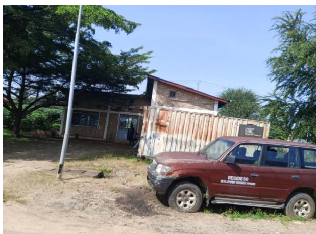
Figure 2 : Emplacement du bureau de la cellule de maintenance des SP sur le site de la SP2
