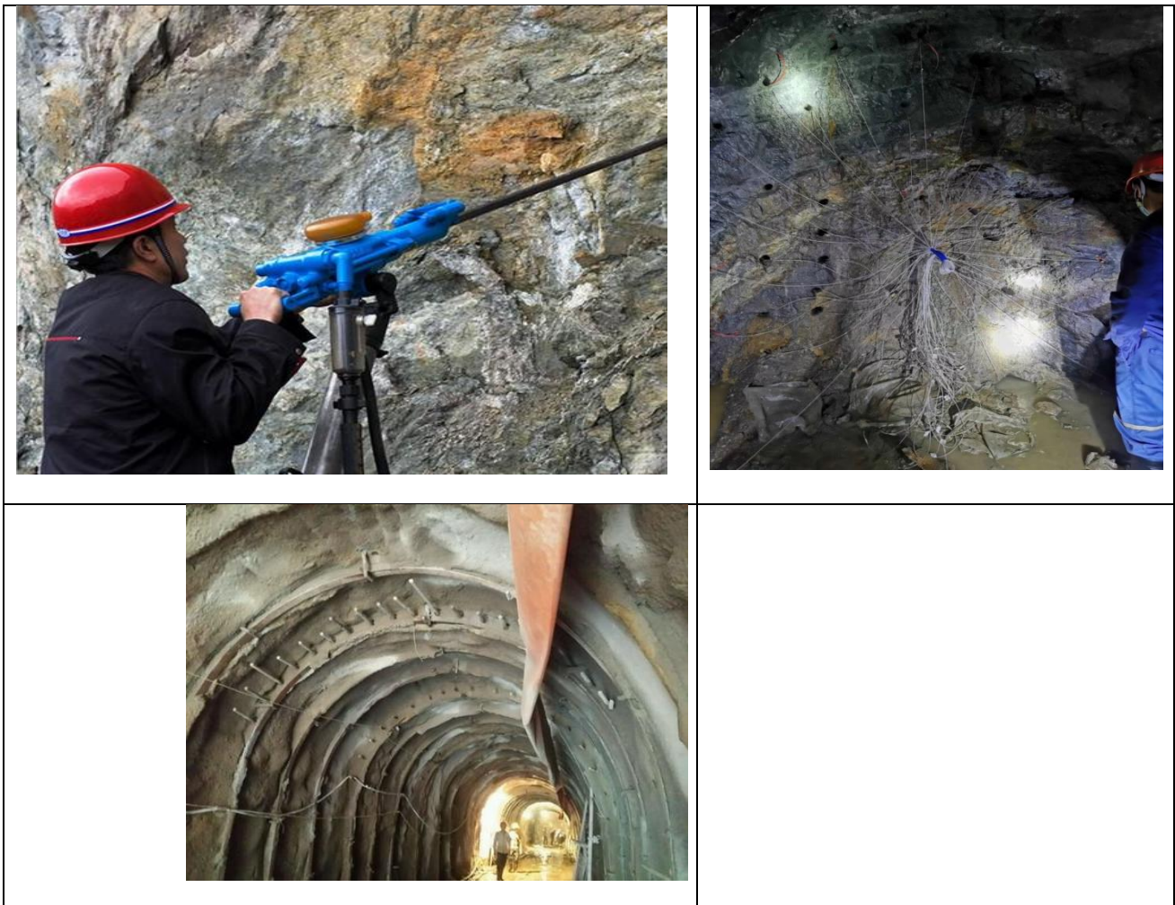
Photo 1: Photo de forage, de bourrage de la charge, de blindage et de ventilation
