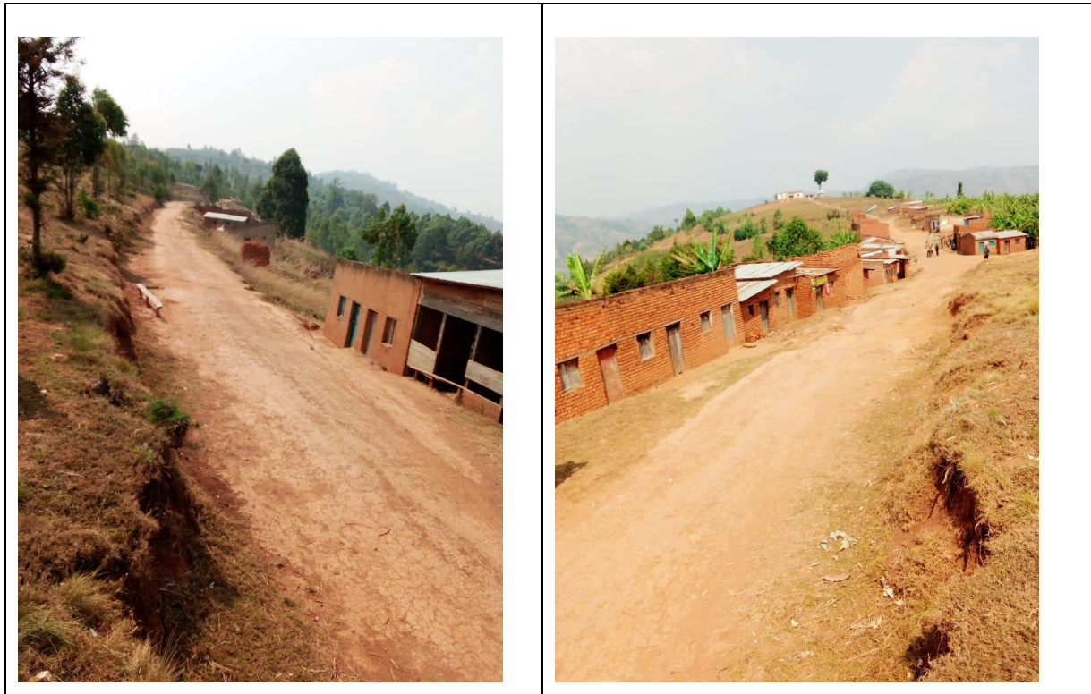
Photo 1:Route PMB Avant réhabilitation
